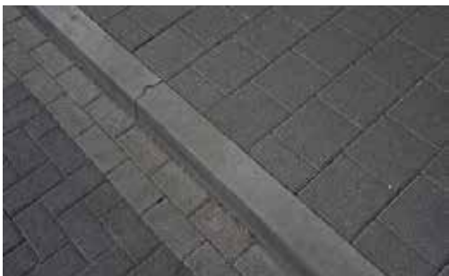
totoirband beton 130/150 x 200 mm StruykVerwo (o.g.)
