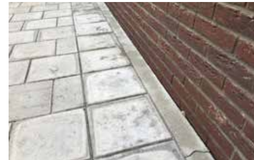
opsluitband beton, 100x200mm, grijs, StruykVerwo (o.g.)
