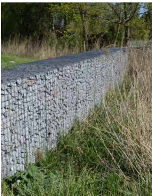
schanskorf gevuld met Grauwacke
