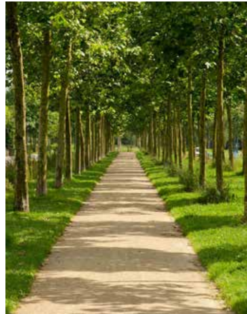
hoofdroute, langzaam verkeer / gerecy- cled beton ecocrete, white topping (o.g)
